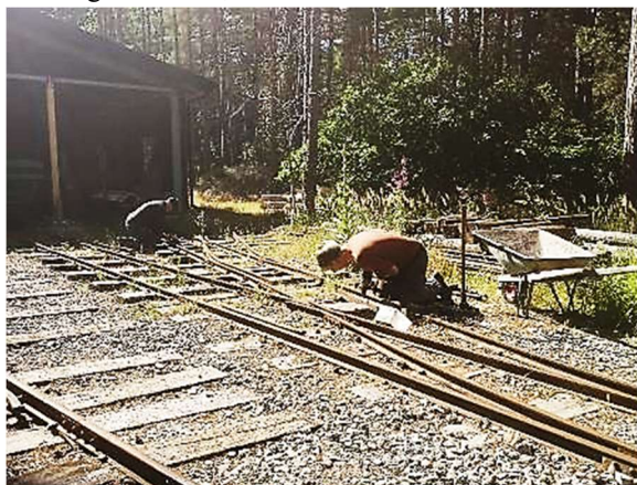
Översyn och justering av spär växlar i Fagerrör 22-07-15.
